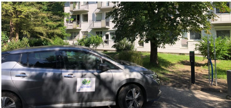
Rys. 2 Jedna z ładowarek do pojazdów elektrycznych zainstalowanych w Spółdzielni Mieszkaniowej Mickiewicza i Nissan Leaf używany do testów (S. Bykuć, IMP, 2024).
