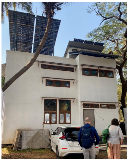
Rys. 5 W IITB zespół Shunya opracował inteligentny budynek neutralny pod względem emisji dwutlenku węgla i przeprowadził związane z nim badania.
